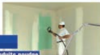
GRACO ULTRA MAX II 1095 PULVÉRISATEUR ÉLECTRIQUE SÉRIE IRONMAN AIRLESS Débit maxi : 4,5 l/mn Pression 227 bars - 1650W Hauteur 75 cm roues semi-pneumatiques Hi-Boy réf. 17E650
